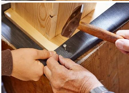
**4 SCHLEIFEN UND FOLIE ANNAGELN** Jetzt werden die Kanten geschliffen. Und die Betontrennfolie wird mit dem Teppichmesser auf rund 30 mal 33 cm zugeschnitten. Damit sie sich gut biegen und satt aufs Holz legen lässt, erwärmt Walter Blaser sie mit einem Föhn und schneidet sie an den Ecken ein.
