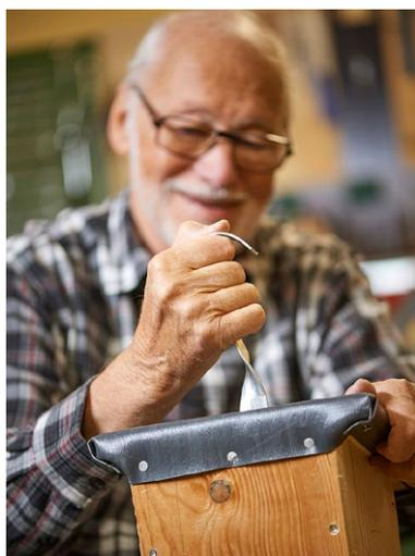
andere Ende in den Schraubstock und biegt es zu einem Bogen. An diesem Bogen wird der Kasten später an einem Ast aufgehängt. Die Aufhängevorrichtung wird mit zwei Schrauben am Dach befestigt (Löcher vorbohren).
